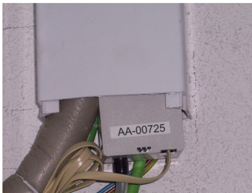
Figura 28 - Etiquetado de Bomba de Condensación
