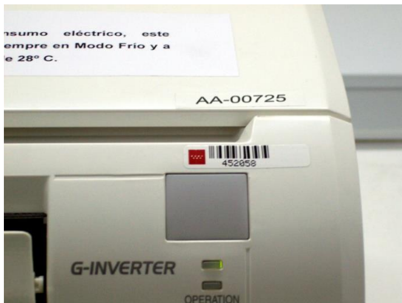
Figura 27 - Etiquetado de Unidad Interior, Consola o Split
