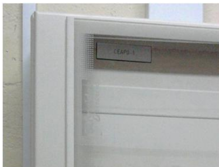
Figura 15 - Etiketado de cuadro eléctrico sin parte fija exterior en el frontal y puerta transparente.
