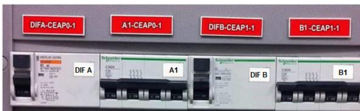
Figura 22 - Etiquetado de Protecciones de Protección de Cuadro en Servicio SAI
