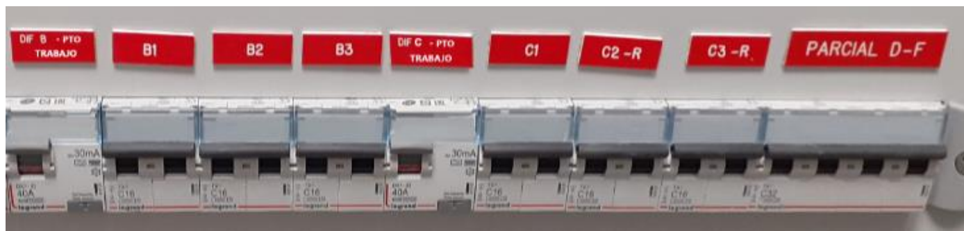
Figura 21 - Etiquetado con placas serigrafiadas autoadhesivas de Protecciones en Servicio SAI
