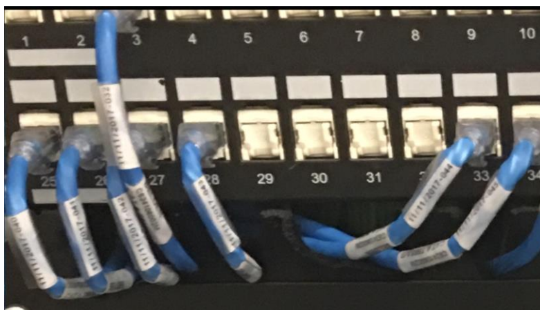
Figura 13 - Etiquetado de latiguillos de cobre entre panel horizontal y equipo switch
