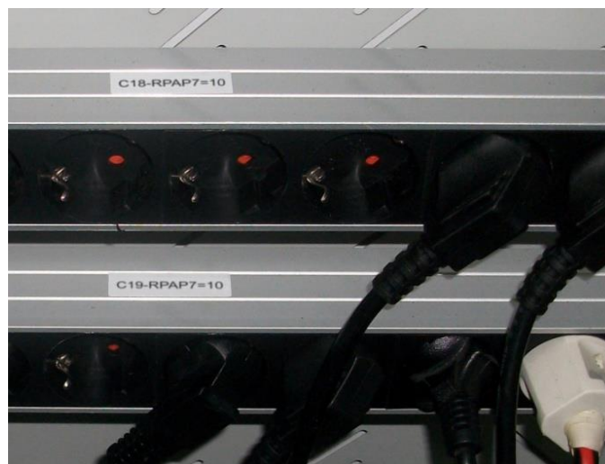
Figura 26 - Etiquetado de Regletas Eléctricas en su Cara Superior
