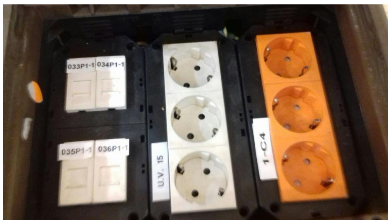
Figura 23 - Etiquetado de Tomas Eléctricas
