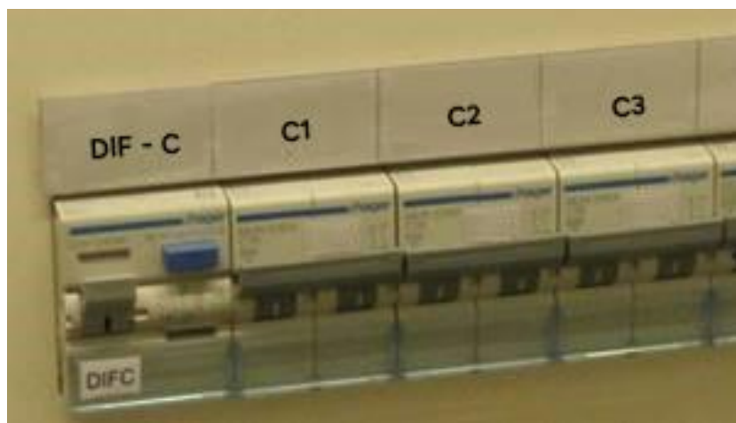
Figura 20 - Etiquetado con portaetiquetas de Protecciones en Servicio No SAI
