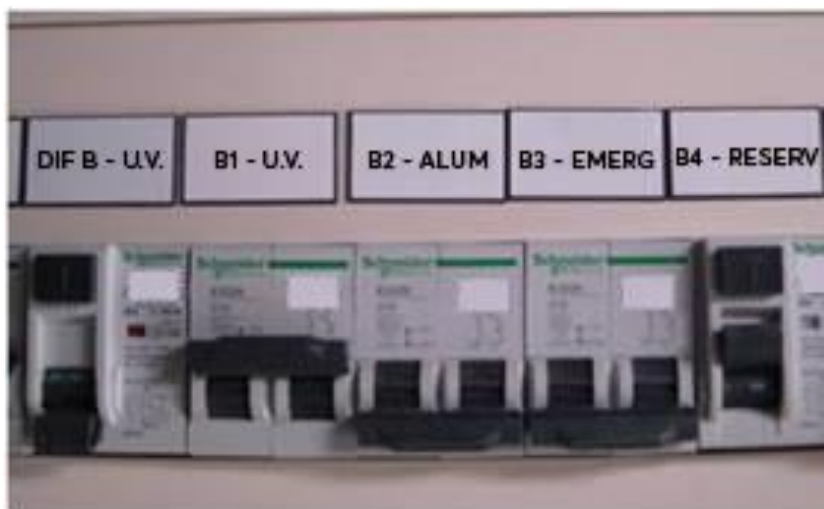
Figura 19 - Etiquetado con placas serigrafiadas autoadhesivas de Protecciones en Servicio No SAI
