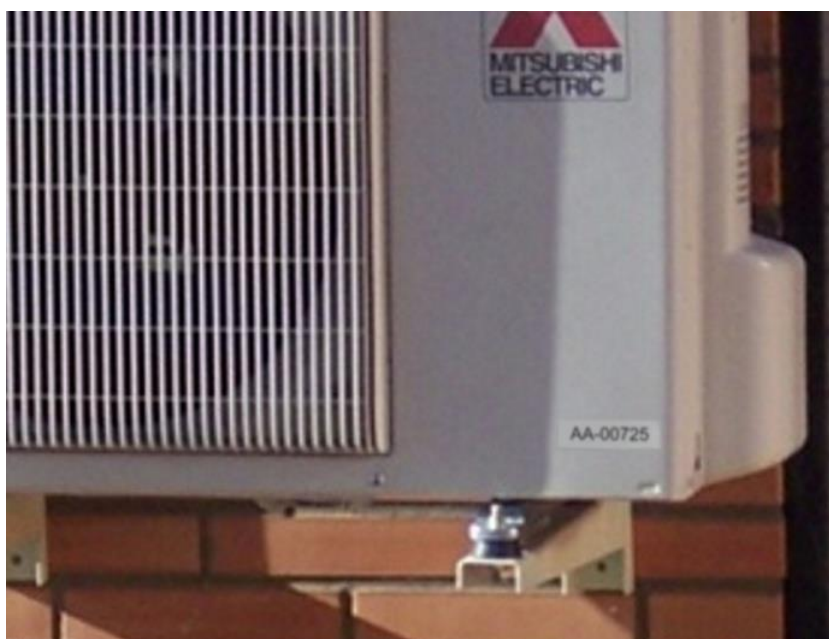
Figura 29 - Etiquetado de Unidad Exterior o Condensadora
