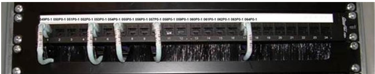
Figura 9 - Etiquetado de puertos en paneles horizontales
